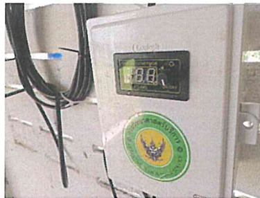
รูปที่ ๖ การติดตั้งระบบฆ่าเชื้อโรคในน้ำประปาหมู่บ้านด้วยรังสีอัลตราไวโอเล็ตแบบอัตโนมัติ เข้ากับระบบประปาหมู่บ้าน
