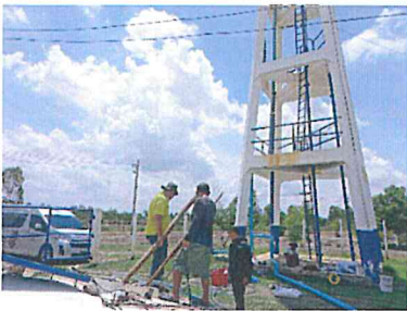
รูปที่ ๖ การติดตั้งระบบฆ่าเชื้อโรคในน้ำประปาหมู่บ้านด้วยรังสีอัลตราไวโอเล็ตแบบอัตโนมัติ เข้ากับระบบประปาหมู่บ้าน
