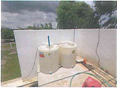
รูปที่ ๕ การติดตั้งระบบเติมสารส้มแบบอัตโนมัติ ที่โรงสูบน้ำดิบ
